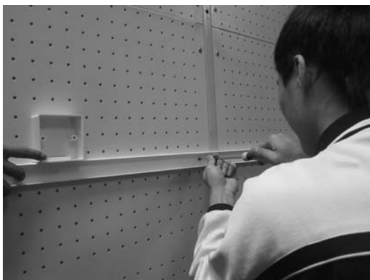
图 2-40 安装线槽
